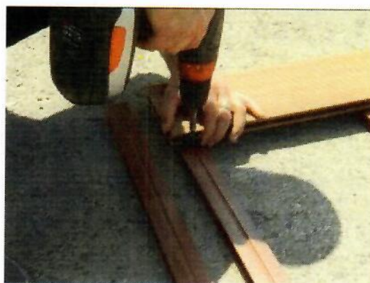
Fig. 3) Fixare clemă de prindere la 3cm de capătul profilului tip WPC
