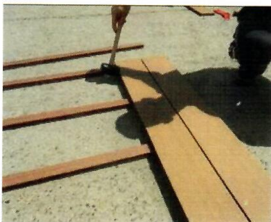
Fig. 4) Glisare profil tip WPC sub clemele deja fixate ale primului profil
