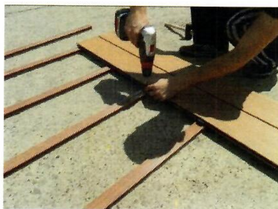
Fig. 5) Fixare clemă de prindere la al doilea profil
